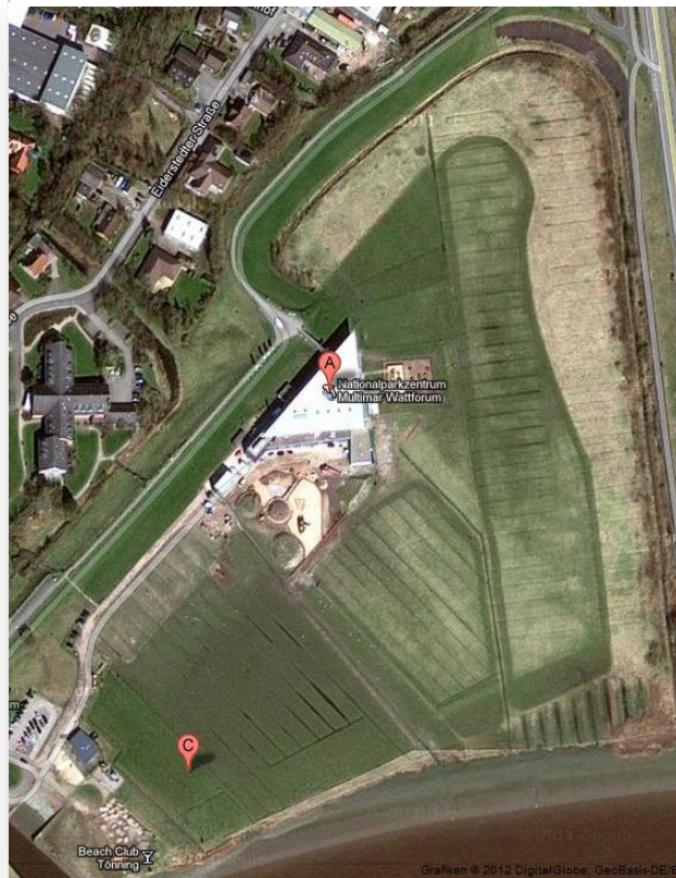
Abbildung 4: Luftbild des Multimar Wattforums
